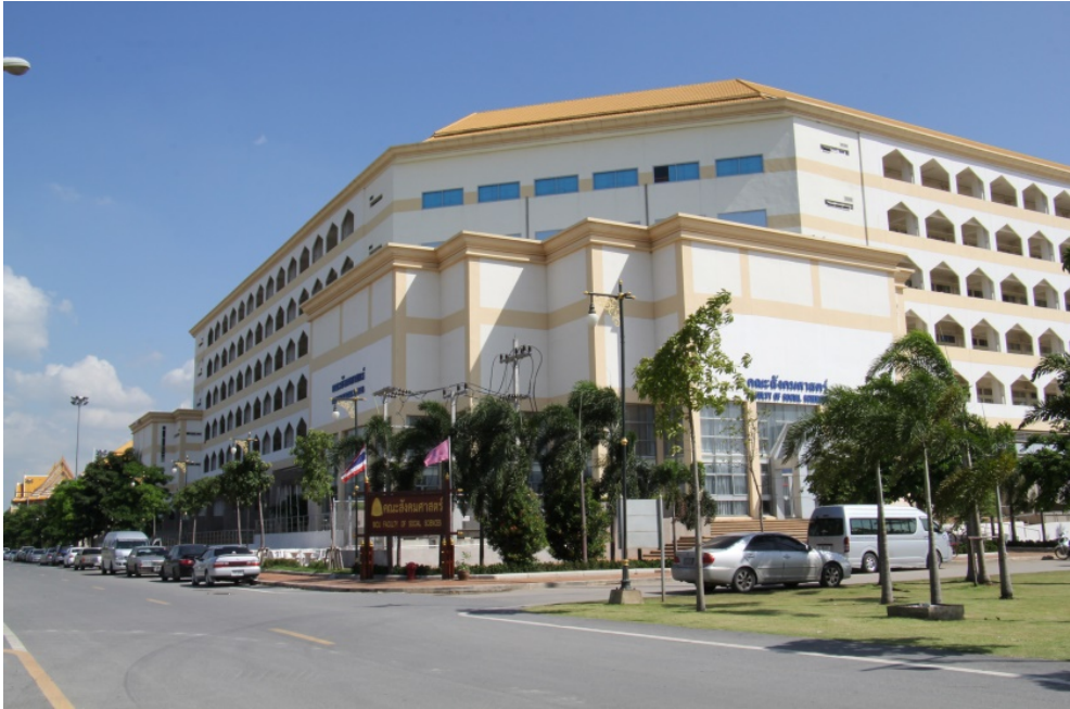
ตึกอาคารเรียนรวม โชน B คณะสังคมาศตวรรษ
